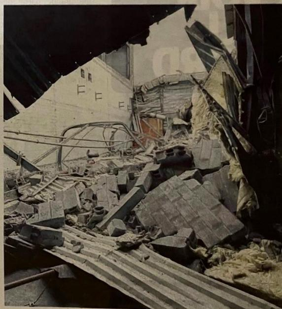
Sous la puissance du vent, le mur coupe-feu en parpaings s'est effondré sur l'un des bâtiments de l'imprimerie.
